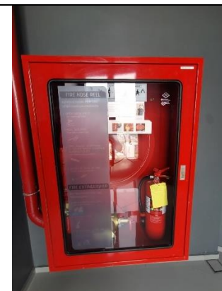
ภาพที่ 24 ตู้เก็บสายฉีดน้ำดับเพลิงพร้อมอุปกรณ์
