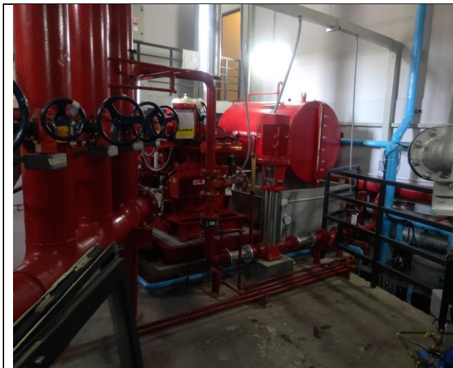
ภาพที่ 22 เครื่องสูบน้ำดับเพลิง (Fire Pump)
