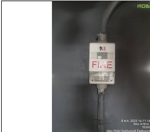
ภาพที่ 32 กริ่งสัญญาณเตือนภัย
